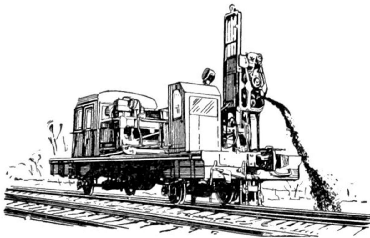
Рис. 2. Рытье котлованов котлованокопателем ВК-1 на дрезине.
